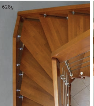
628g Stufenbolzen in Wandwange
