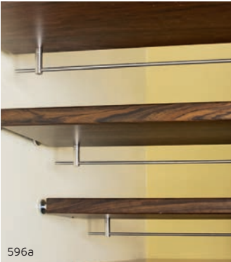
Leisten unter den Stufen verringern den Abstand
