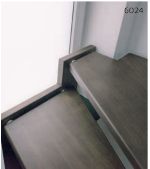
6024 Holzwange im Fenster
