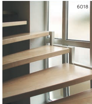
6018 Stahlwange im Fenster
